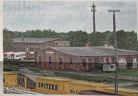
Der historische Lokschuppen an der Max-Johannsen-Brücke ist 150 Jahre alt und verfügt über eine Drehscheibe für Dampflokomotiven. Davor liegt ein Areal, das für Güterumschlag genutzt wird.
