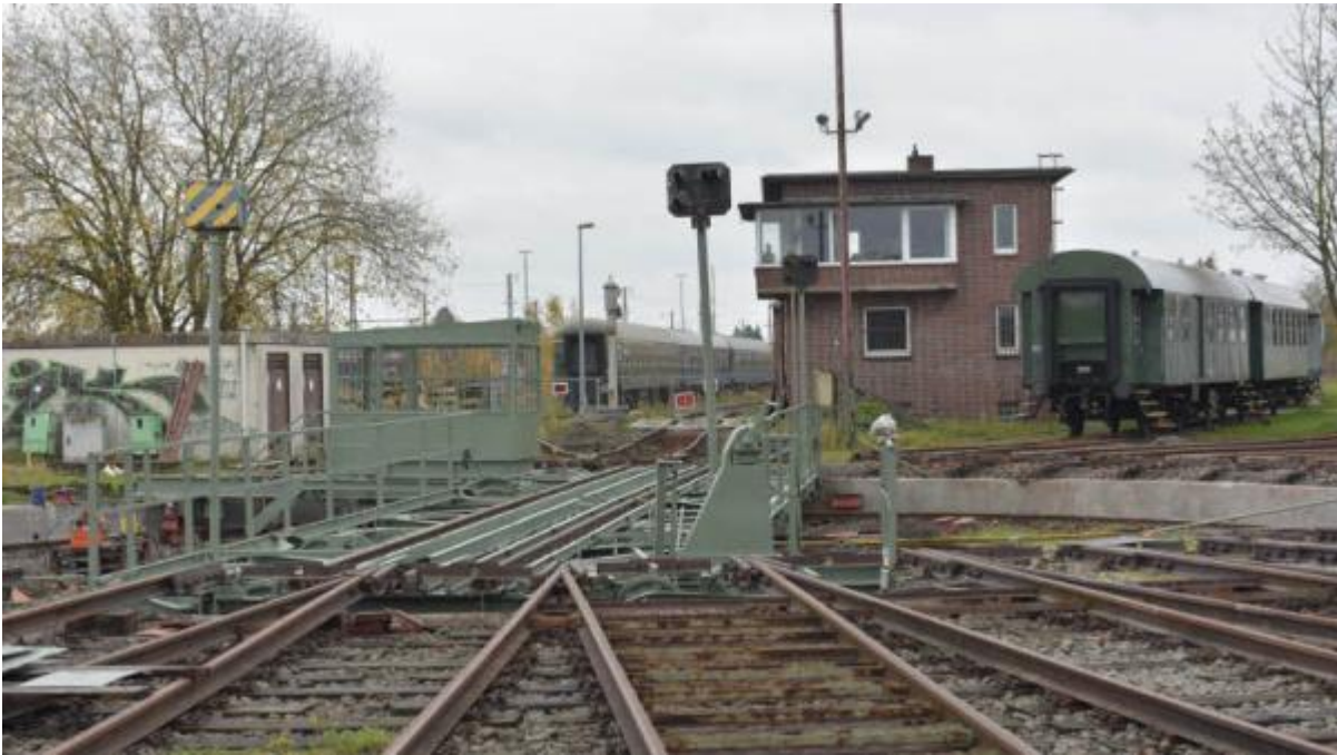
Die Arbeiten an der Drehscheibe sind fast fertig.
