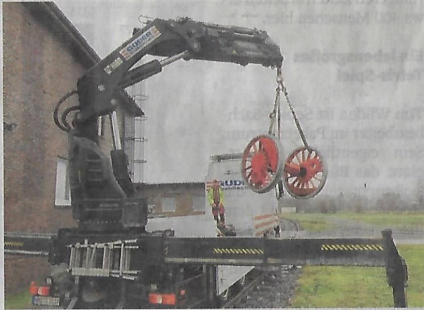
Dennis Schings von der Firma Guder manövrierte die schwere Achse mit einem Kran vom Lkw auf das Gleisstück vor die Lokleitung.
