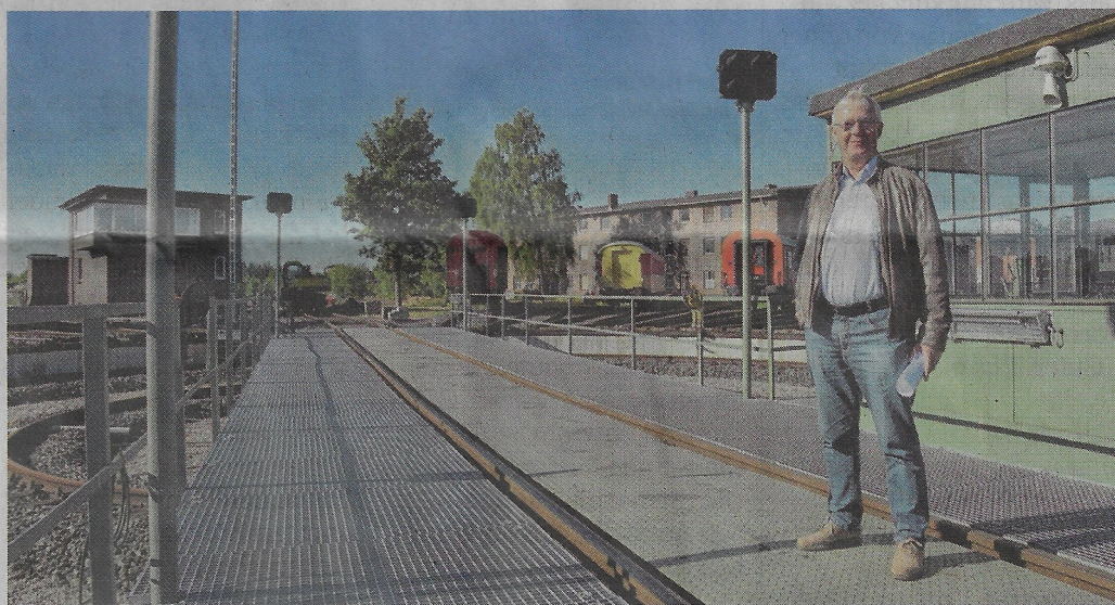
Dr. Thomas Kittel steht auf der fertig sanierten Drehscheibe mit dem Steuerhaus. Foto: Rolf Ziehm
