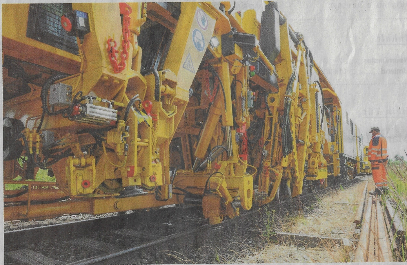
34 Meter lang ist die Stopfmaschine, die den Schotter unter den Gleisen und Schwellen verdichtet.
