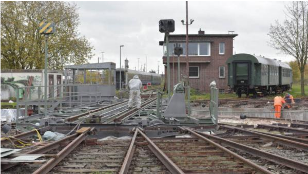
Stahl- und Betonbauer sanieren die Drehscheibe am Lokschuppen.
