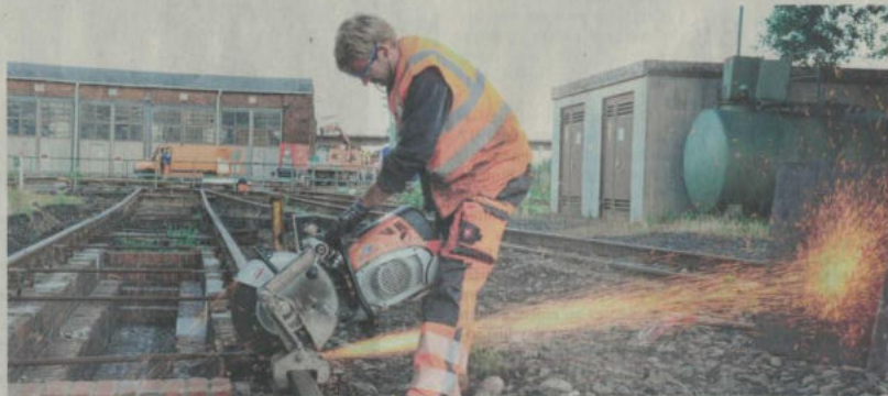
Pierre Züge schneidet mit der „Schienenflex“ durch ein Gleis. Den Funkenflug soll die aufgestellte Platte ein wenig bremsen. FOTOS: ZIEHM
