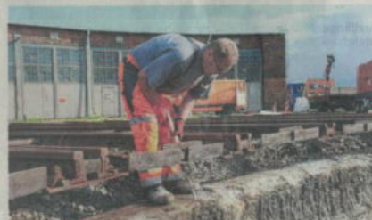
Raimund Gemser beseitigt am Betonring der Drehscheibe mit dem Bohrhämmer loses Material.
