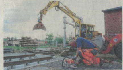
Baggerfahrer Axel Maaß und Wolfgang Züge tauschen die alten Holz- gegen neuere Betonschwellen aus.
